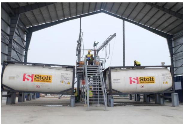
Depósito de tanques Haiphong
